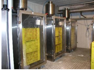
الغرف المبردة التي يتم التحكم فيها في المناخ
